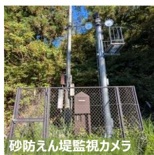
大正12年の大災害の教訓から、上田沢上流で土石流等が発生した場合、上田沢流域の耕作地、居住地、鉄道、国道等に甚大な被害が発生すると予想されます。夜間でも大型投光器によりカメラ監視できる施設となっています。現在国交省が大桑村内でカメラ監視している砂防えん堤はここだけです。同じ一級河川である二反田川の砂防えん堤監視カメラは10月末現在配信停止しています。
